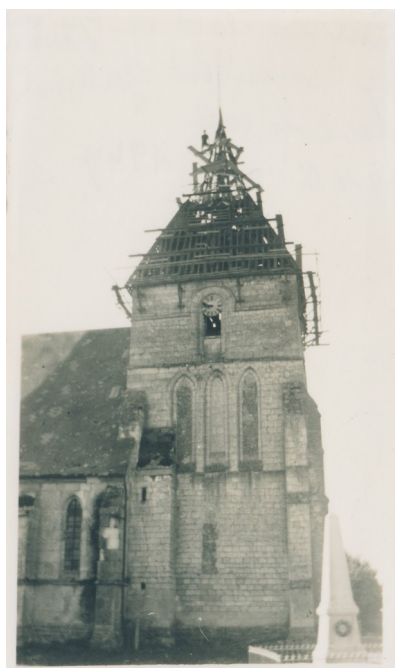
Réparations du clocher et pose de la girouette en 1947 suite aux dégâts provoqués par la foudre
